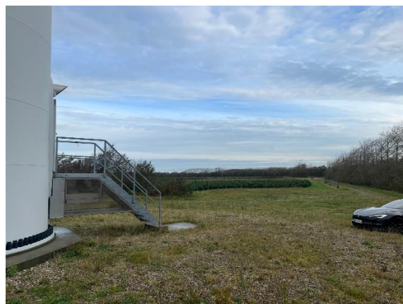
Møllekranplads ved sydligste mølle
